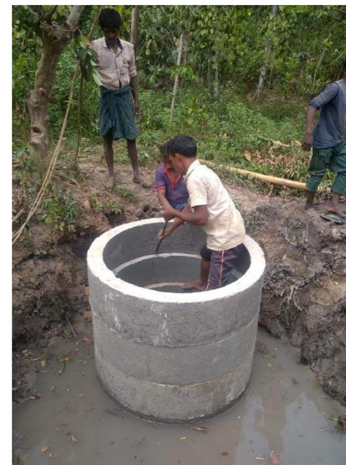
13.3. Im Adivasi-Dorf Pudhur helfen Jugendliche, einen Brunnen zu reinigen und zu reparieren. (Foto: AMS)
