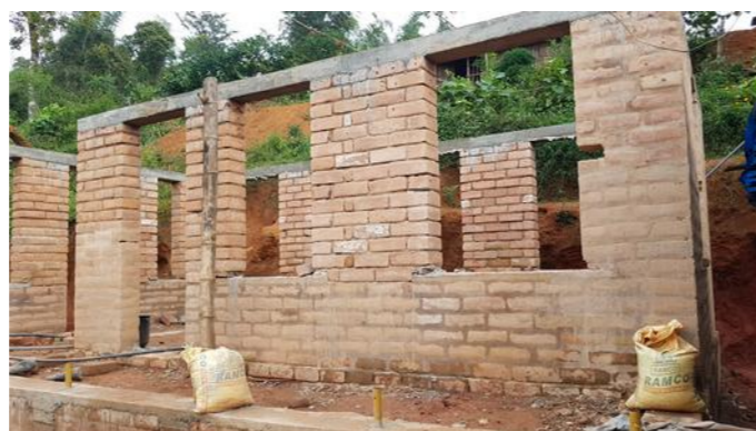
Altes Haus (Foto 10.1.2. oben) und neues Haus (Foto 10.1.3. unten) im Adivasi-Dorf Kottaimed. Hier gibt es keinen Strom. (Fotos: Adivasi-Tee-Projekt)
