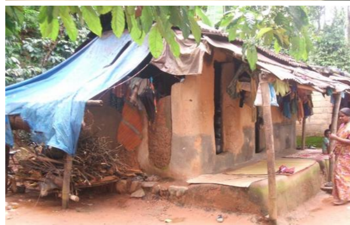
14.1.1. Ein traditionelles Lehmhaus mit Grasdach. 14.1.2. Reparaturbedürftiges Adivasi-Haus. Fotos: Adivasi Munnetra Sangam (AMS)
