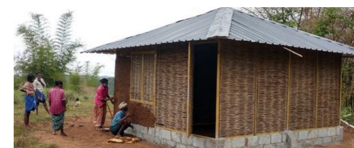
14.3.2. Das neue Haus ist fertig gebaut. Jetzt werden die Wände noch mit Lehm verkleidet.
