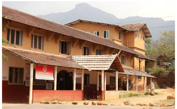
5.6. das „Gudalur Adivasi Hospital“ in den Nilgiri-Bergen
